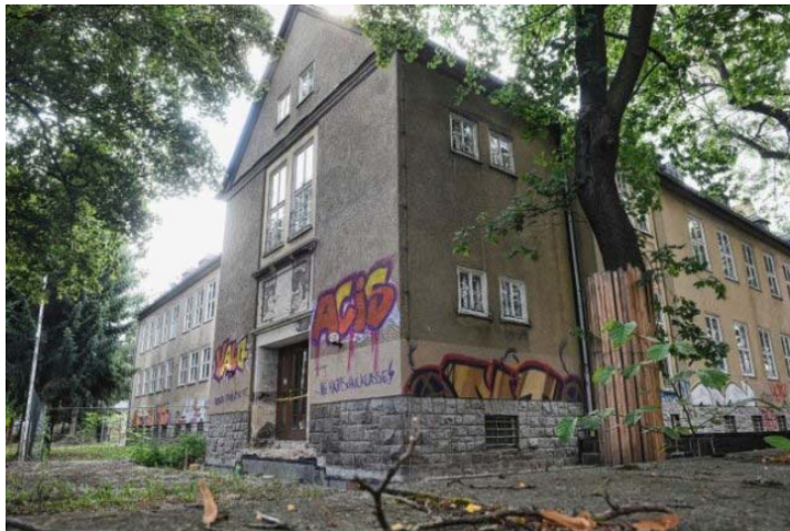
Alter Schulstandort Weststraße
